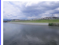
現場状況（令和7年4月） (護岸整備実施中)
