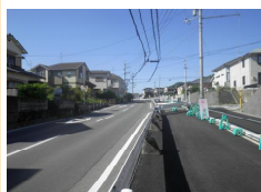
現場状況（令和6年4月） (道路拡幅整備実施中)
