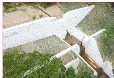
砂防堰堤（令和4年8月完成）
