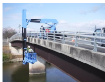
橋梁点検実施状況 (岡井二箇堂線 三郷橋) (大和郡山市八条町)
