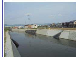
現場状況（令和7年4月） (護岸整備実施中)
