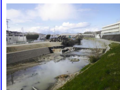
現場状況（R7年4月） (護岸整備実施中)
