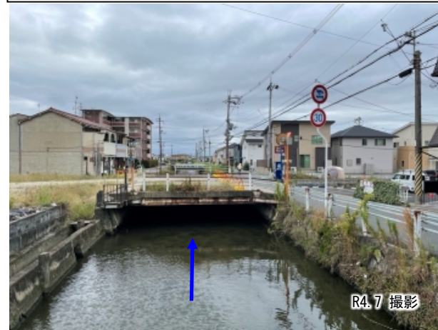
② 暗渠部より下流 (未改修)
