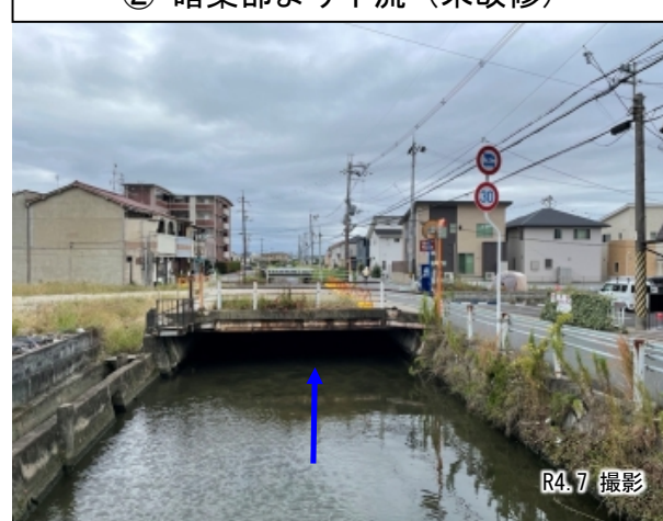
② 暗渠部より下流（未改修）
