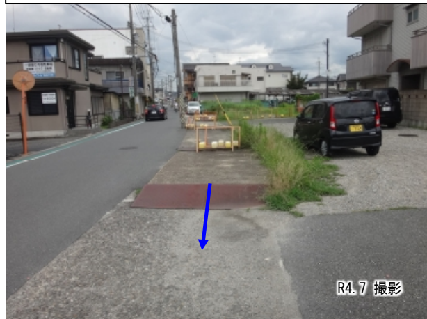
①JRより下流の暗渠部 (未改修)
