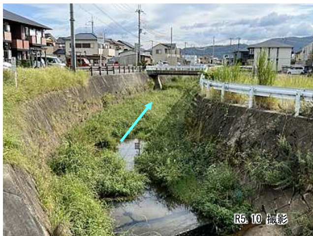
①菰川橋南詰交差点付近 (2.6km付近、改修済み)
