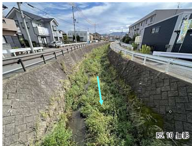
②大芝橋上流 (2.7km付近、改修済み)
