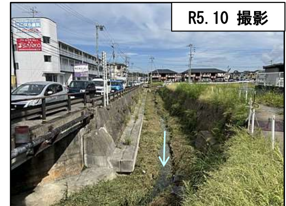
①無名橋より上流部 (整備済み区間)
