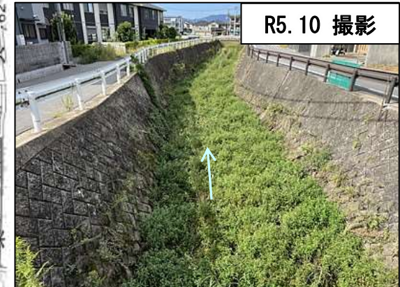
②大芝橋より下流部 (整備済み区間)
