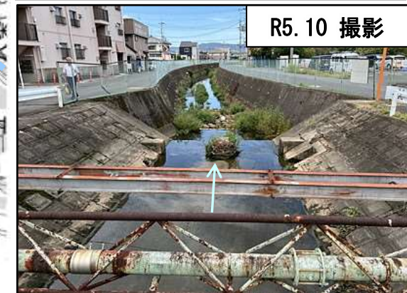
③神明橋より下流部 (未整備区間)
