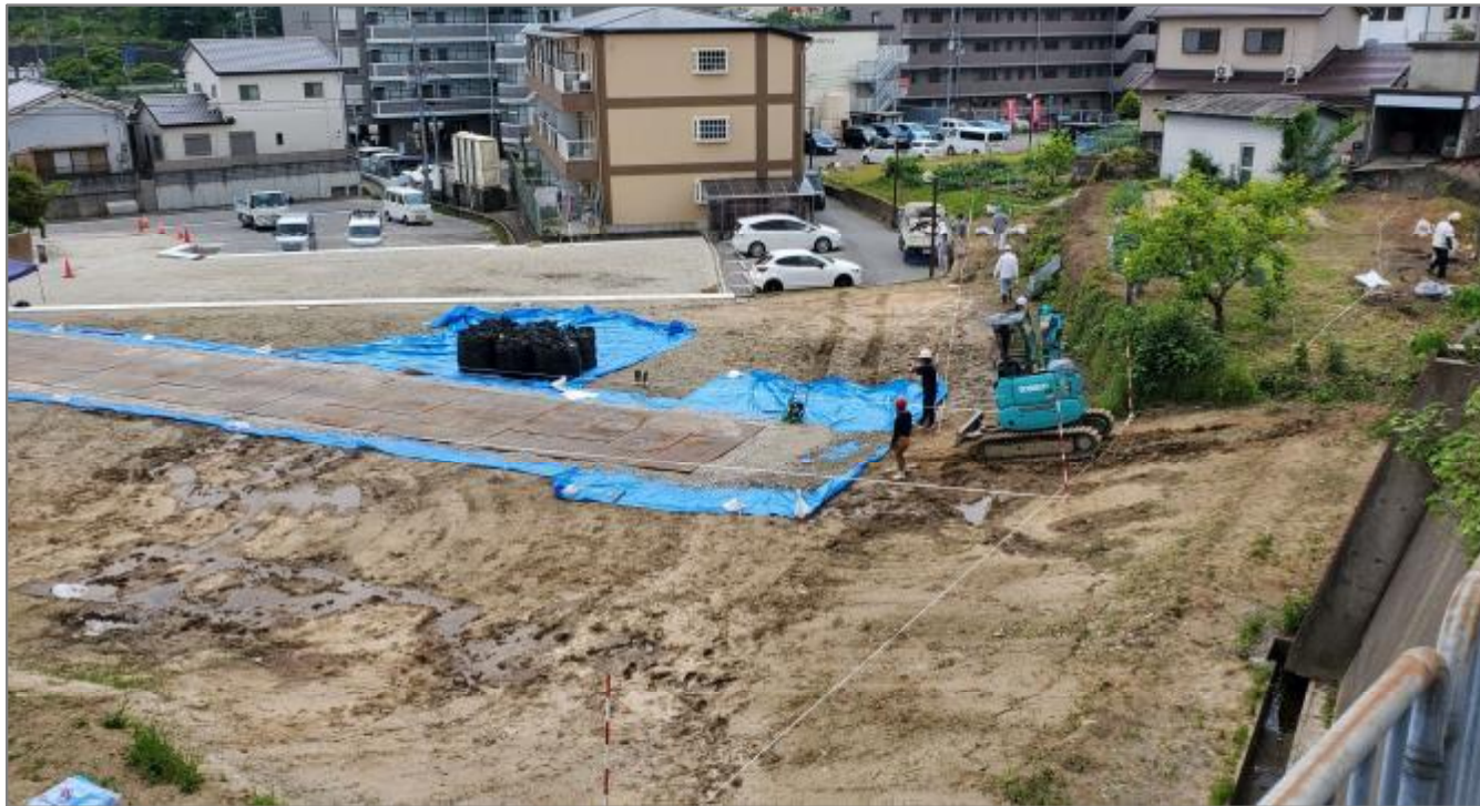
大型土のう設置のための 工事用進入路の設置状況
