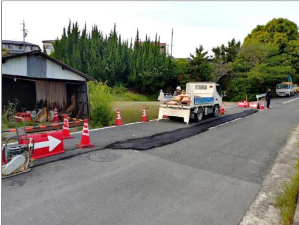
ひび割れ部分をレミファルトで 応急復旧
