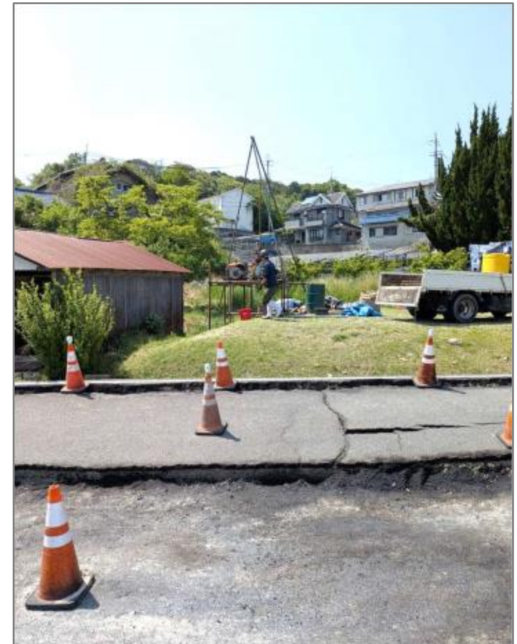
ボーリング調査実施状況
