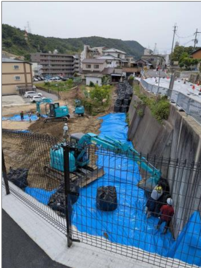
大型土のう設置状況
