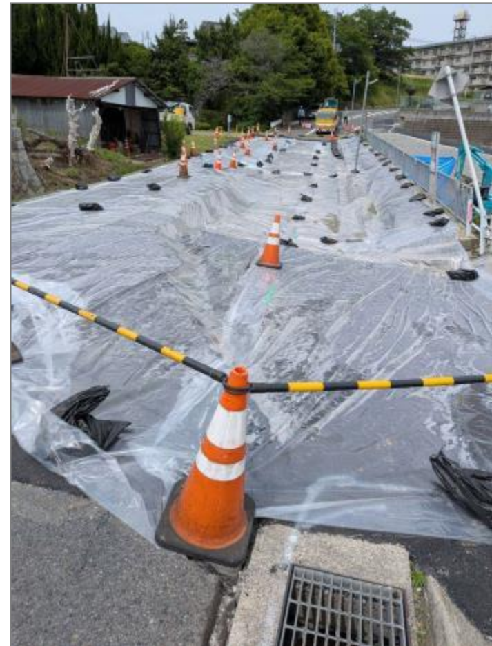
シート設置状況（防水対策）
