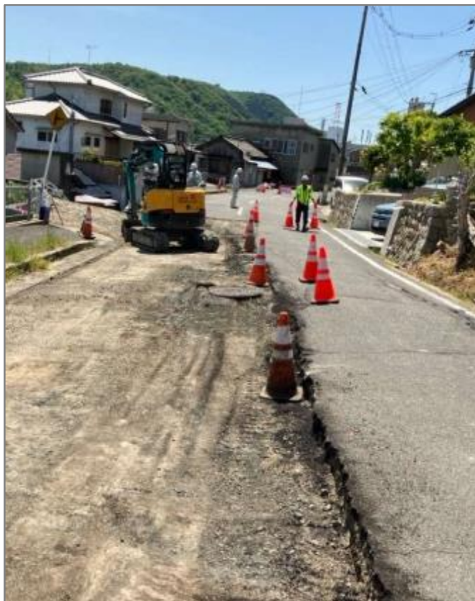
舗装撤去状況①
