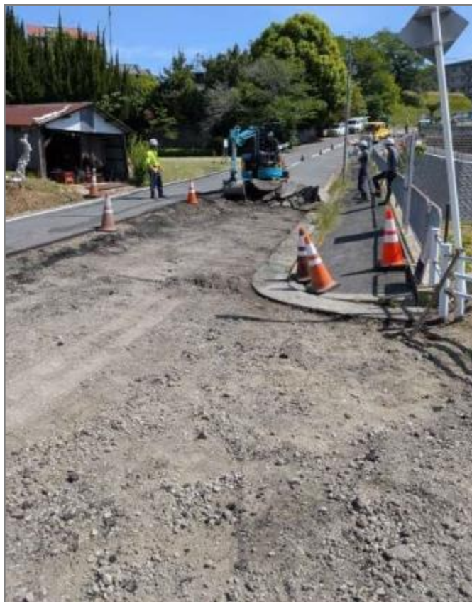
舗装撤去状況②
