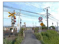
D 中八条踏切道 （農道）
