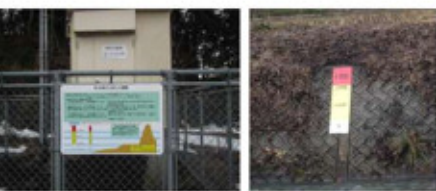
▲ 見やすい量水標の設置 野尻川（尾花沢市野尻沢）
