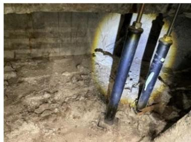
メインアリーナ鋼製床下スラブの損傷
