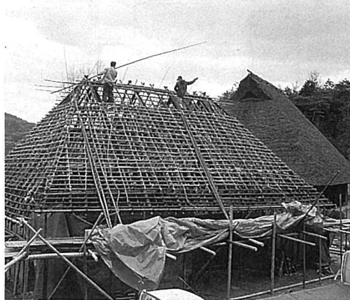
▲屋根カゴをつくる
