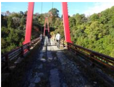
両エリアをつなぐ橋
