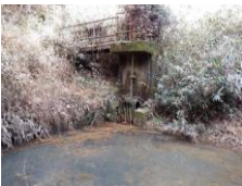
写真1 東エリア内の横断管の流入口
