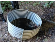
写真4 西エリア内の横断管の流入口
