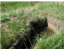
写真3 東エリア内の水路、排水柵
