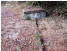
写真2 東エリア内の横断管の流入口(排水樹)
