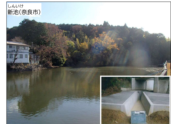
余水吐の改良(R6年度施工)
