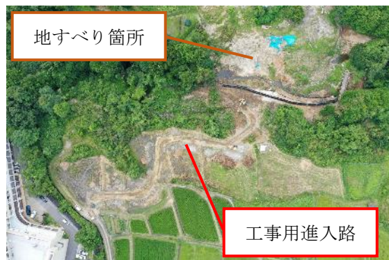
写真2. 工事用進入路設置後
