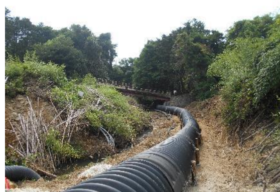
写真3. 排水管設置後
