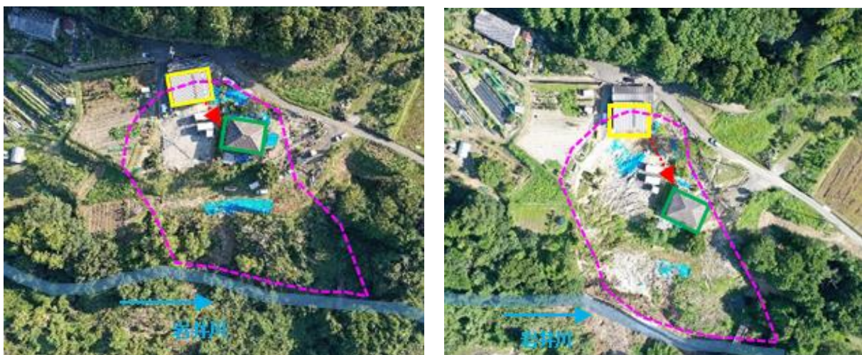
写真1 地すべり状況
