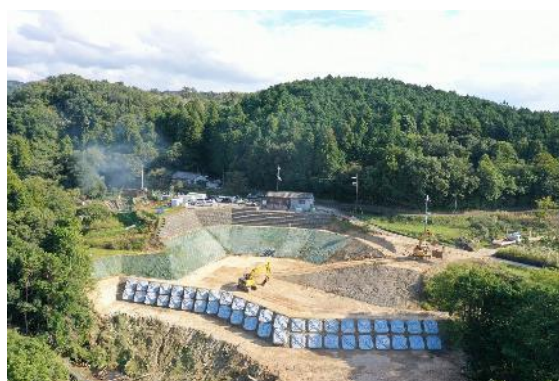
写真4. Ⅰ期工事完成時
