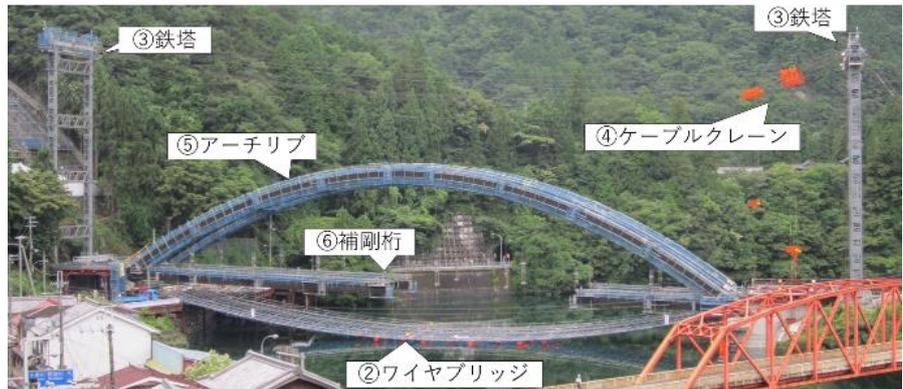
写真-6 補剛桁架設途中の様子
