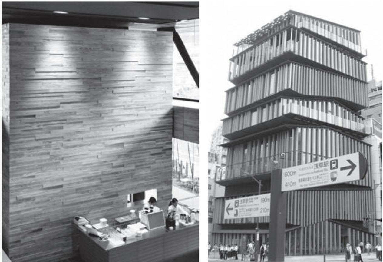
図11 開発した吸湿性が低い不燃木材の実用化例
