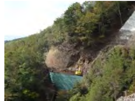
林道川津今西線4号(土工施工中) 平成26年10月17日撮影
