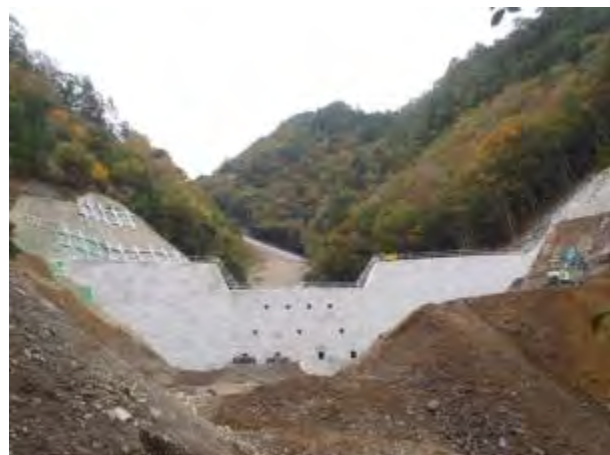
平成26年10月31日撮影 (砂防堰堤設置状況)
