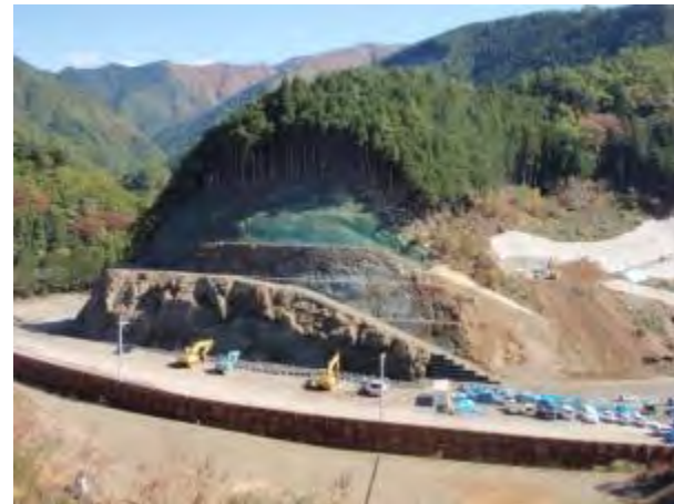
平成26年10月30日撮影 (河道掘削状況)
