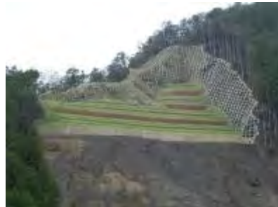
木製土留工、木製筋工完成 平成26年10月21日現在
