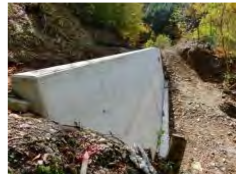
林道コノ谷線4号(完成) 平成26年10月29日撮影
