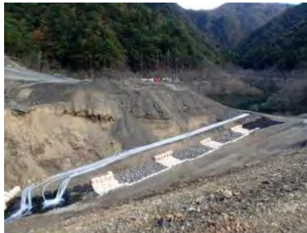
平成26年10月30日撮影 (仮排水路設置状況)
