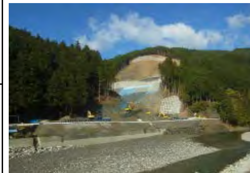
高野天川線(天川村南日裏) 平成26年10月28日撮影
