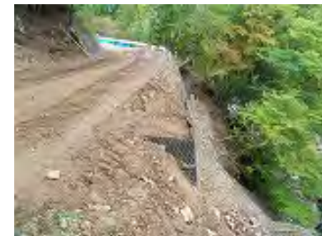
林道殿野坪内線6号(補強土壁工完了) 平成26年10月22日撮影
