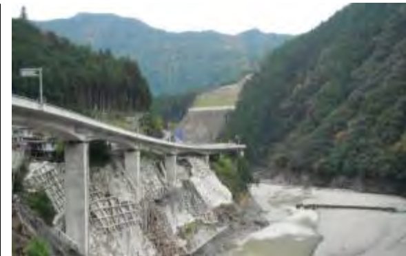
十津川道路(平成26年10月29日撮影)
